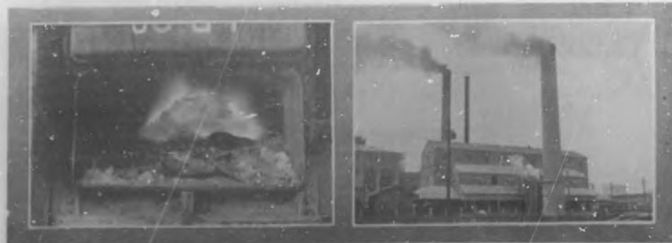
EL HORNO CREMATARIO.—Una interesante fotografía de la hornilla de uno de los hornos.—Vista del edificio construido por los F. C. Unidos en Tallapiedra para quemar las basuras de la Ciudad.
